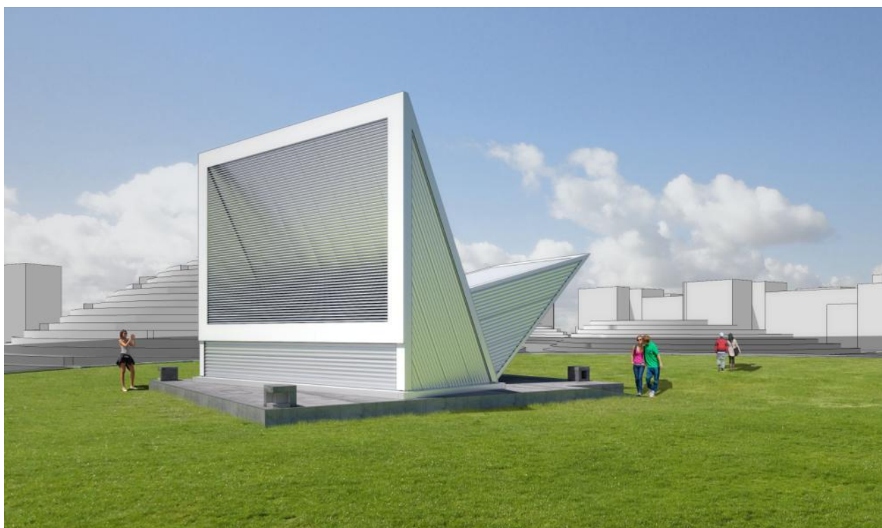
Figura 1.4.9: Dettaglio della mitigazione dei camini di esalazione della cabina di trattamento aria della viabilità Gattamelata interrata (Unità 2A)
