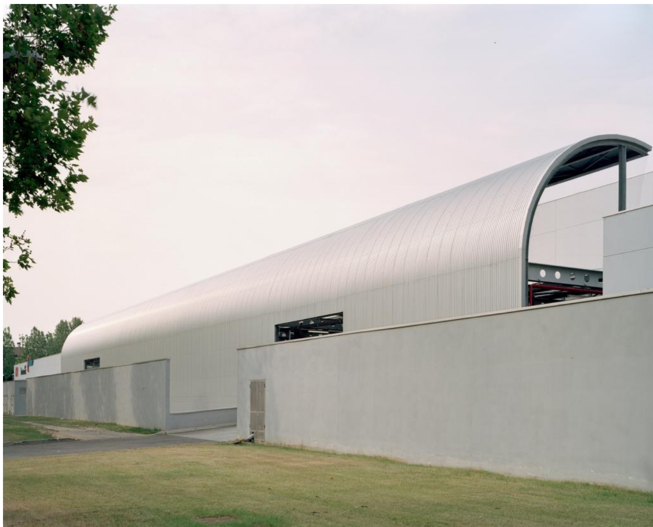
Figura 1.4.7: Struttura di mitigazione acustica apposta sul retro della grande struttura di vendita (Unità 2A)
